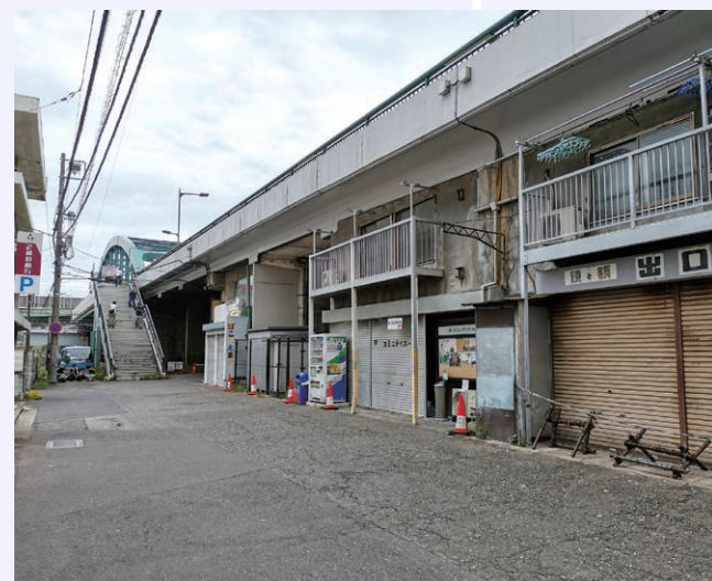
図2 大栄橋補強工事にもない高架下店舗の退去が進む
