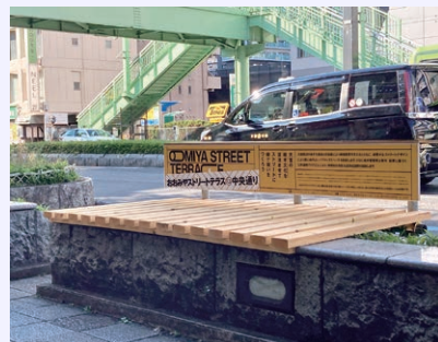
図2 歩道の植栽帯の上に設置された仮設デッキ「道床(ミチドコ)」
